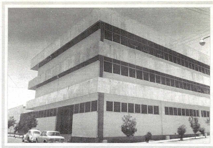
Edificio de la Casa de la Cultura de Gómez Palacio, Durango
